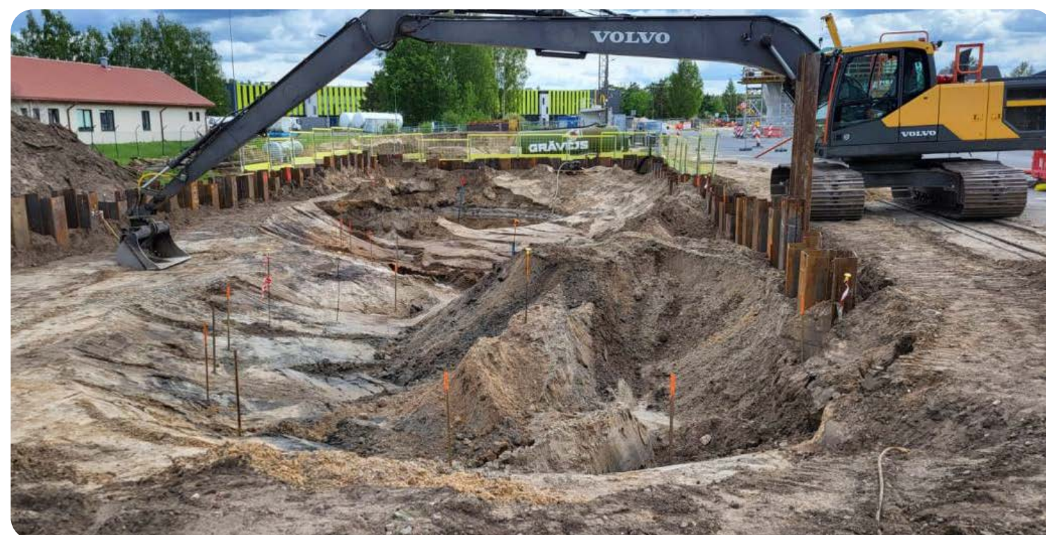
6. attēls. Sanācijas darbu gaita pie vecās DUS (AS “BAO” atskaite par veiktajiem sanācijas darbiem)
