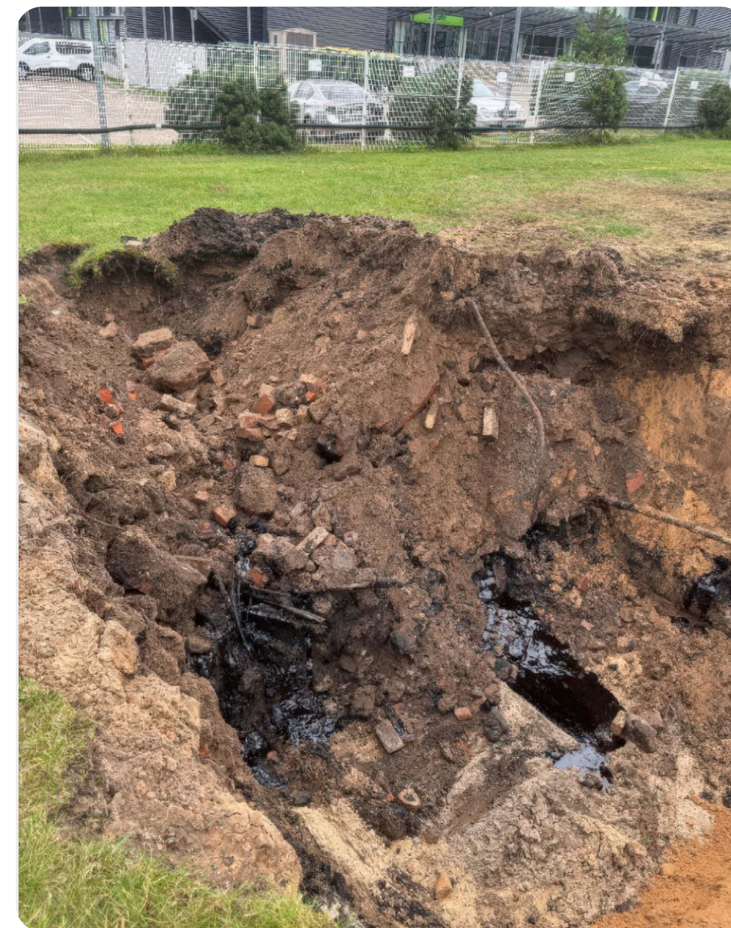
7. attēls. Augsnes piesārņojums ar mazutu un būvgružiem
