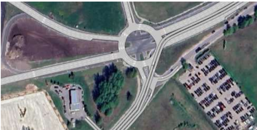
Attēls 28 – Krustojums, kas pārveidots par apļveida krustojumu un estakādi (līdz 2040. gadam) Avots: "Ineco"
